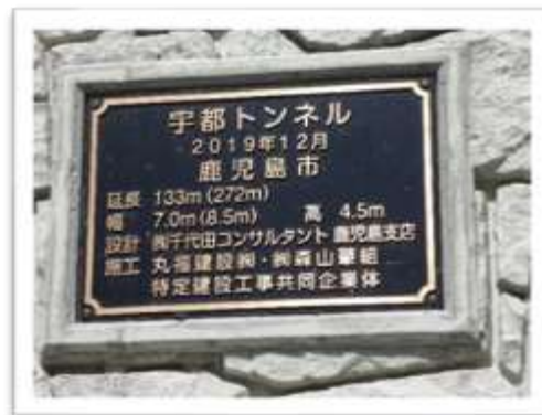
トンネル銘板
