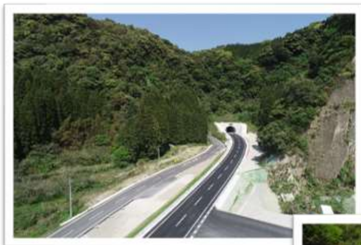
上空からの宇都トンネル
