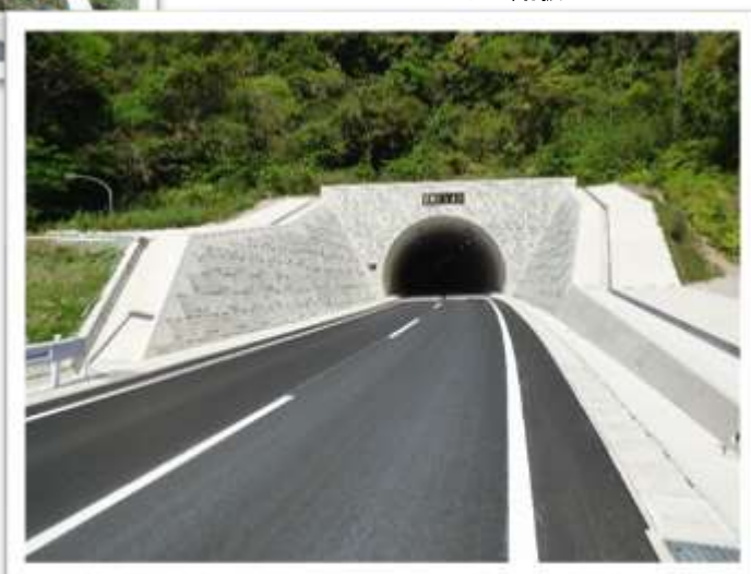
正面からの宇都トンネル
