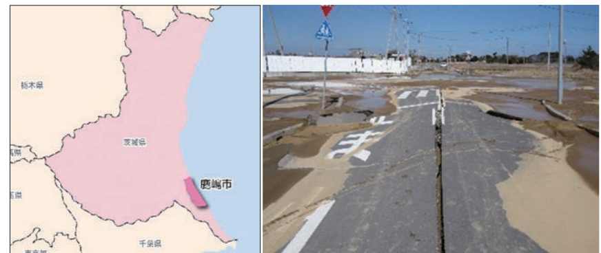
図1 鹿嶋市の位置図 写真1 平井東部地区の液状化被害
