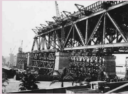
写真2 建設中のアプローチ部
