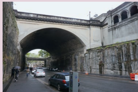
写真6 アーガイルカットにかかる南岸アプローチ部
