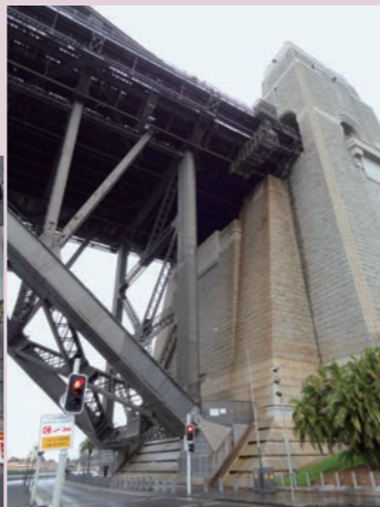
写真7 南岸のヒンジ支承とパイロン
