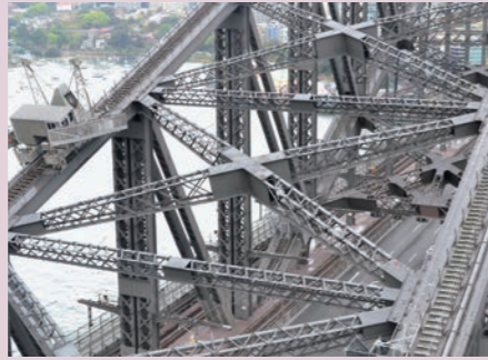
写真4 可動式メンテナンス設備と鋼材を組み合わせた形状の部材
