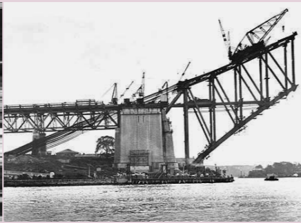
写真3 建設中のアーチをケーブルで引っ張り、アーチ上をクローラークレーンが走る
