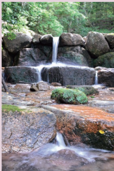
写真3 庭園砂防内の流路工
