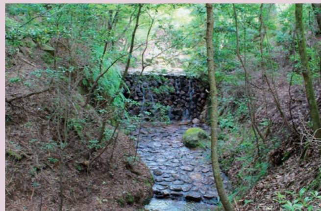
写真4 上流部の砂防堰堤
