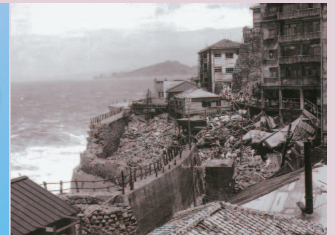
写真4 1956年の台風9号による被害
