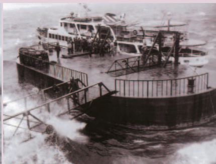
写真9 1962年頃の三代目ドルフィン棧橋
