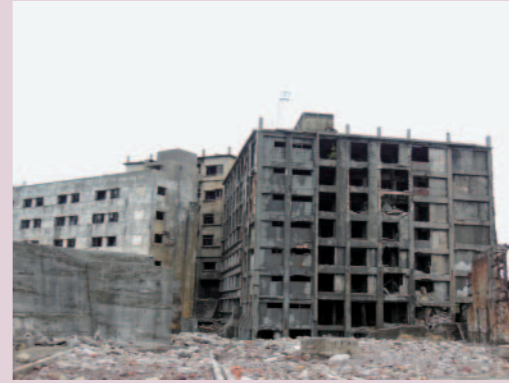
写真11 日本最古の鉄筋コンクリートの高層アパート(右側)
