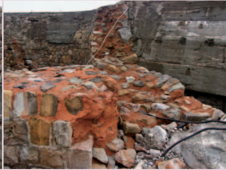
写真6 天川で接合されている石積み護岸内部
