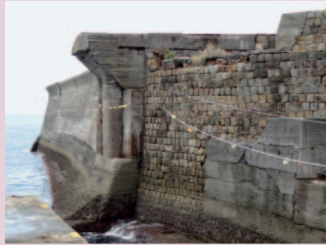
写真5 天川で接合されている石積み護岸とコンクリート補強護岸
