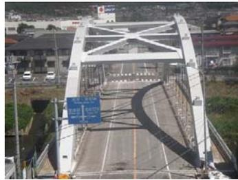
写真-2 補強上支材・上横構
