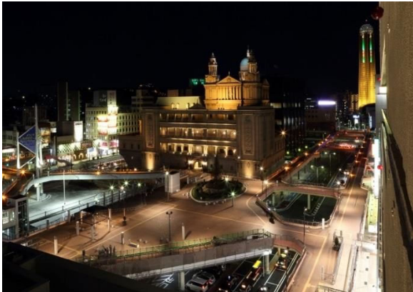
下関駅前人工地盤
