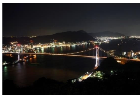
(写真2) 火の山展望台から見た関門橋
