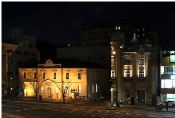
建物のライトアップの演出例（下関南部町郵便局、旧秋田商会ビル）
